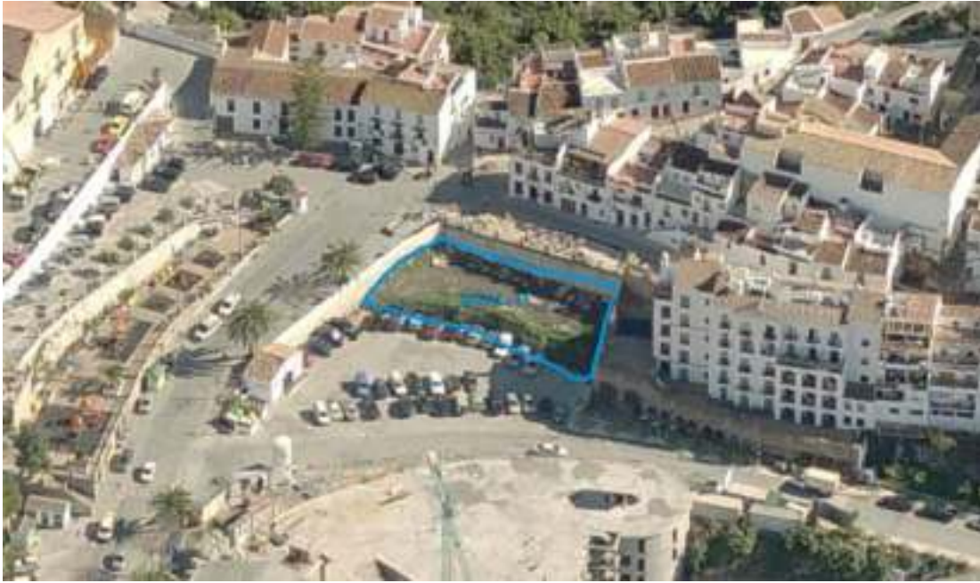
SGAL-11. ESTADO ACTUAL
